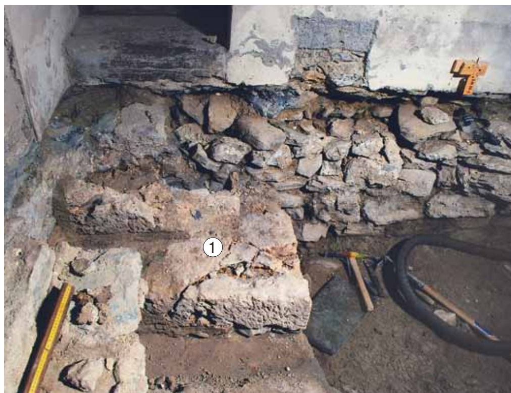
Abb. 21: Tamins, evangelisch-reformierte Kirche. Renovation 2010/11. Kirche 3b.
