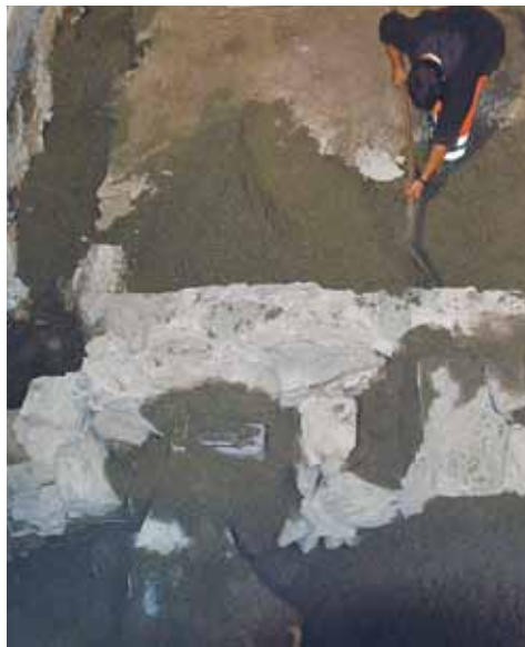
Abb. 5: Tamins, evangelisch-reformierte Kirche. Renovation 2010/11. Nach Abschluss der archäologischen Untersuchungen werden die Sondiergräben und freigelegten Mauern der Vorgängerkirchen zur Sicherung mit Sand eingedeckt. Blick gegen Osten.
